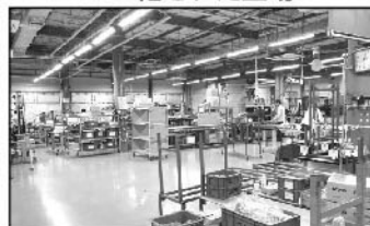
LED化された工場
